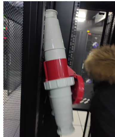
图 10: 山东大学青岛校区数据中心的防爆插头
